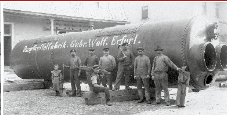
▲ Dampfkessel aus der Dampfkesselfabrik Gebrüder Wolf in Erfurt um 1900
